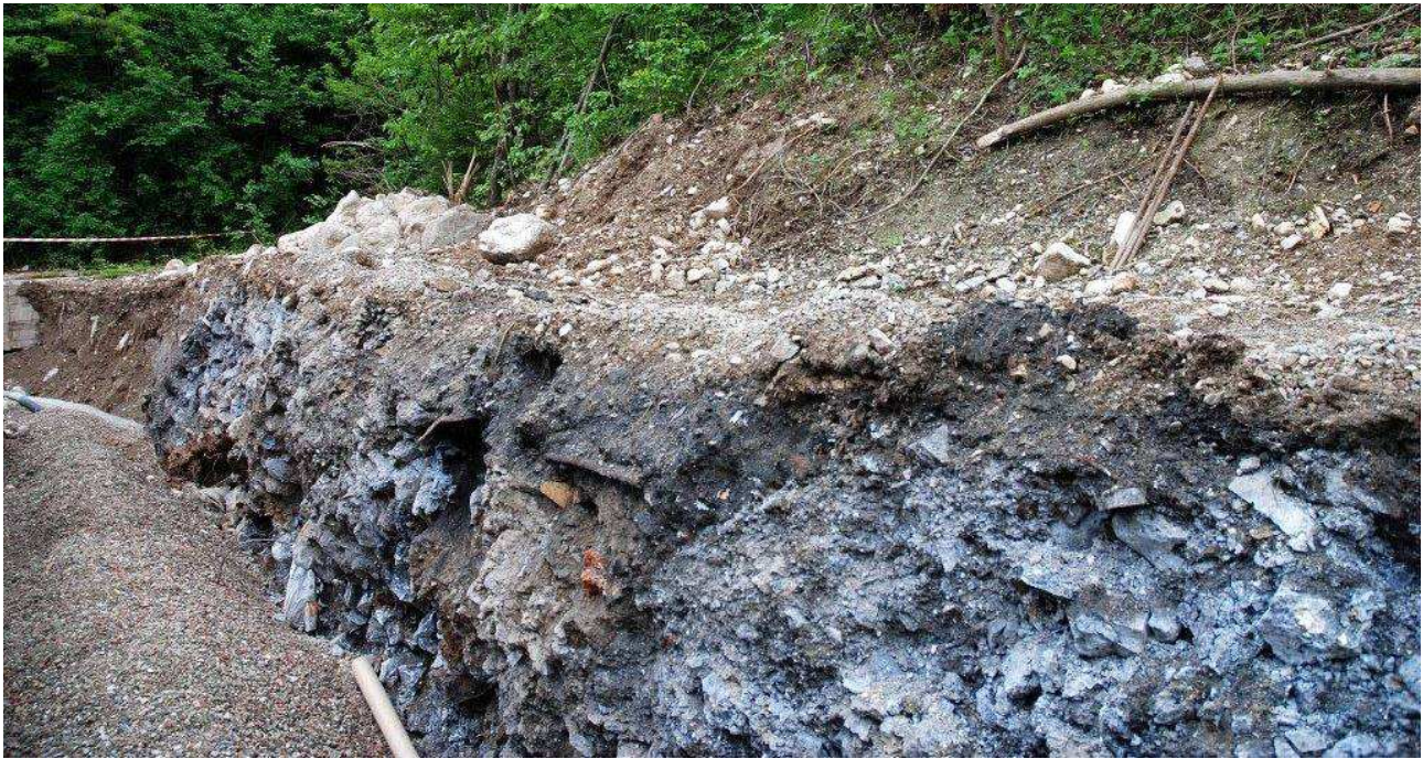
Foto 1 Trincea della condotta forzata e scorie in evidenza
